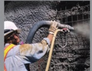
Tokom nanošenja betona prskanjem
