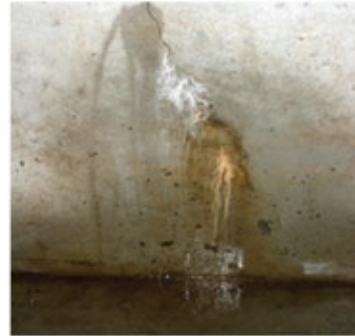
Curenje vode između betonskih spojeva
