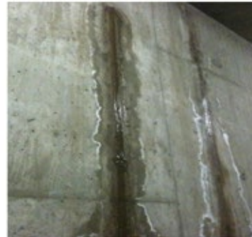
Curenje vode između betonskih spojeva
