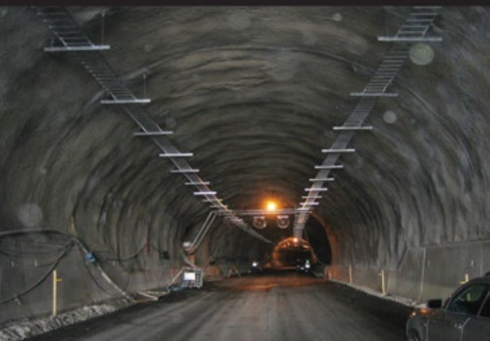
Vuoli Tunnel, Finland
