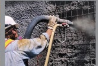
Tokom nanošenja betona prskanjem
