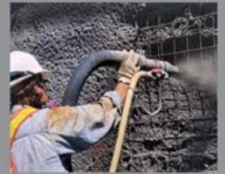
Tokom nanošenja betona prskanjem
