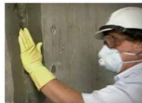
Zatvaranje pukotina
