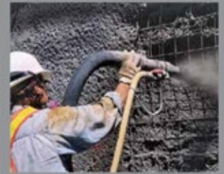
Tokom nanošenja betona prskanjem
