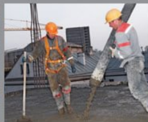
Betoniranje na licu mesta
