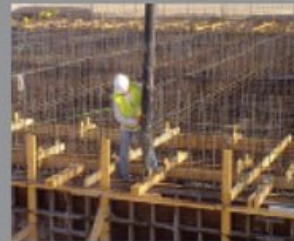
Betoniranje na licu mesta
