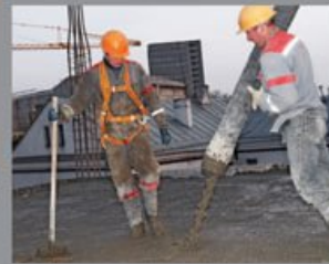
Betoniranje na licu mesta
