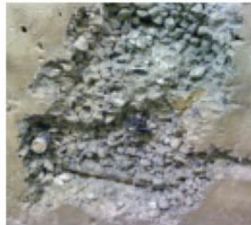
Oštećenje na konstrukciji (segregacija betona, pukotina, pogrešno izvedenih građevinskih spojeva i saća)
